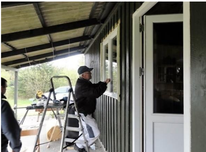
Preben, Steen, Carsten og Kim knokler i 2015 med at få de sidste vinduer og døren sat i.
